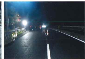
舗装補修完了イメージ
